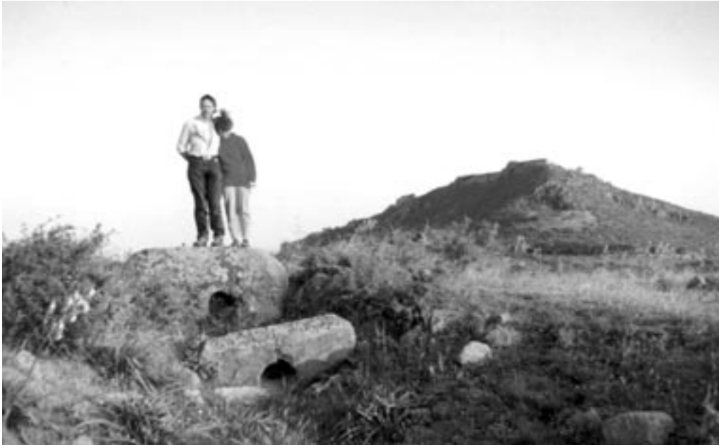
Figuur 27: Madradag sifon bij Pergamon, top Kaleardi Tepe, geperforeerde stenen ter fixatie van de loden leiding. Op de achtergrond de acropolis van Pergamon.
