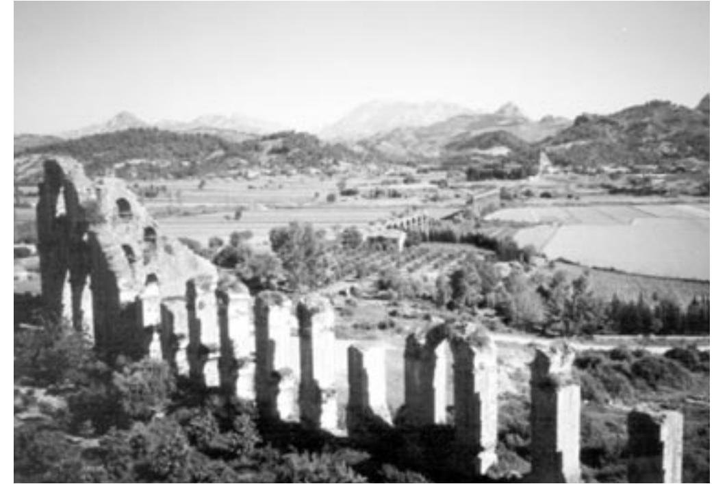
Figuur 42: Aspendos sifon, zuidelijke toren, met in de verte de grote sifonbrug en de noordelijke toren.
