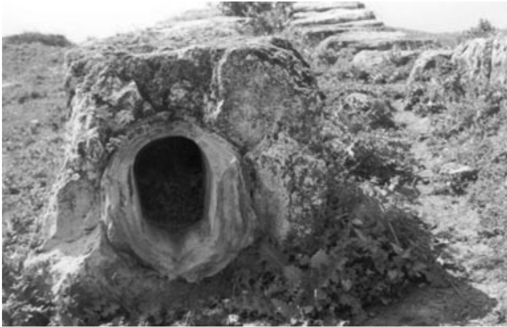
Figuur 25: Kalkafzettingen in de leiding van de Laodikeia sifon.
