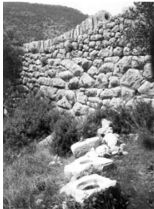
Figuur 22: Delik Kemer sifon van het Patara aquaduct, kalkstenen leidingelementen 90x90x50 cm.
