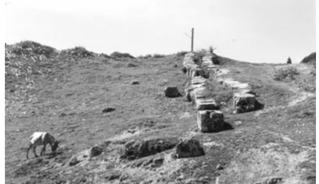
Figuur 23: De dubbele stenen sifon van Laodikeia a/L., bij Pamukkale (Turkije), afdalende been. De headertank bevond zich bij de elektriciteitspaal boven op de helling.
