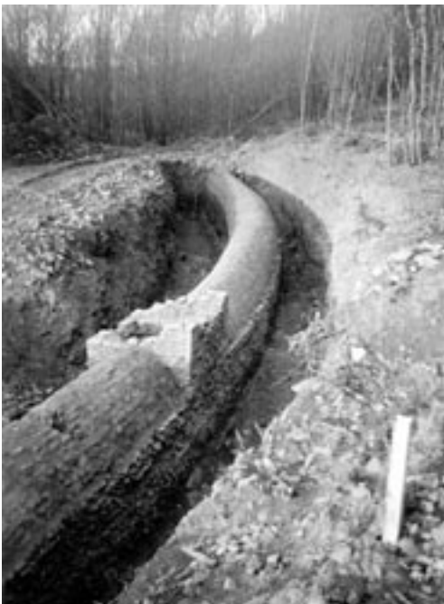
Figuur 7: Opgegraven kanaal van het 95 km lange aquaduct van Keulen, met 'Einstiegschacht' (foto: K. Grewe).
