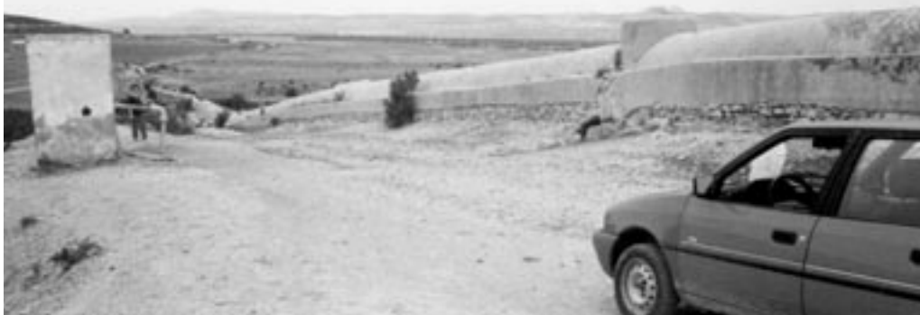
Figuur 13: Aquaduct van Carthago, kanaal kort na beginpunt bij Zaghouan, met sterk dalende gradiënt.
