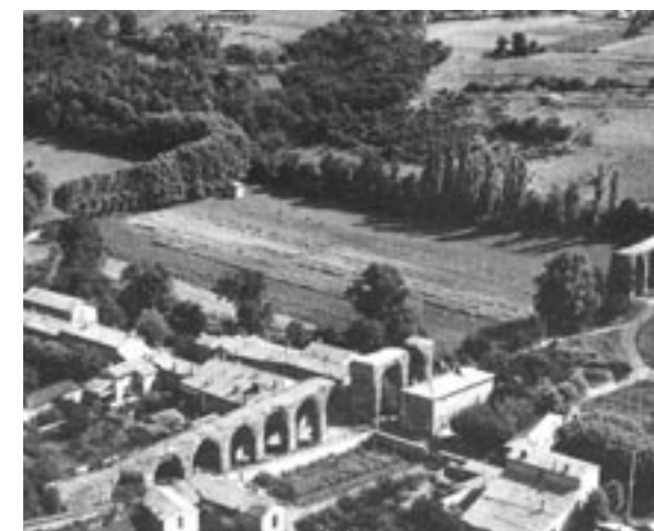
Figuur 18: Sifonbrug van de Yzeron sifon van het Gier aquaduct (opname 1950), genoemd 'Pont de Beaunant' (Burdy 1996).
