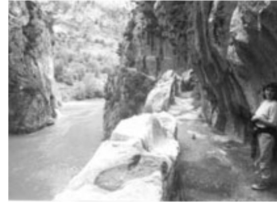
Figuur 3: Kanaal van het aquaduct van Side (zuidkust van Turkije), uitgehakt in loodrechte rotswand bovenlangs de Manavgat rivier.
