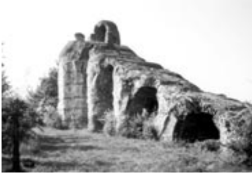
Figuur 19: Header tank van de Yzeron sifon van het Gier aquaduct, met afdalende hellingbaan (bij Chaponost).
