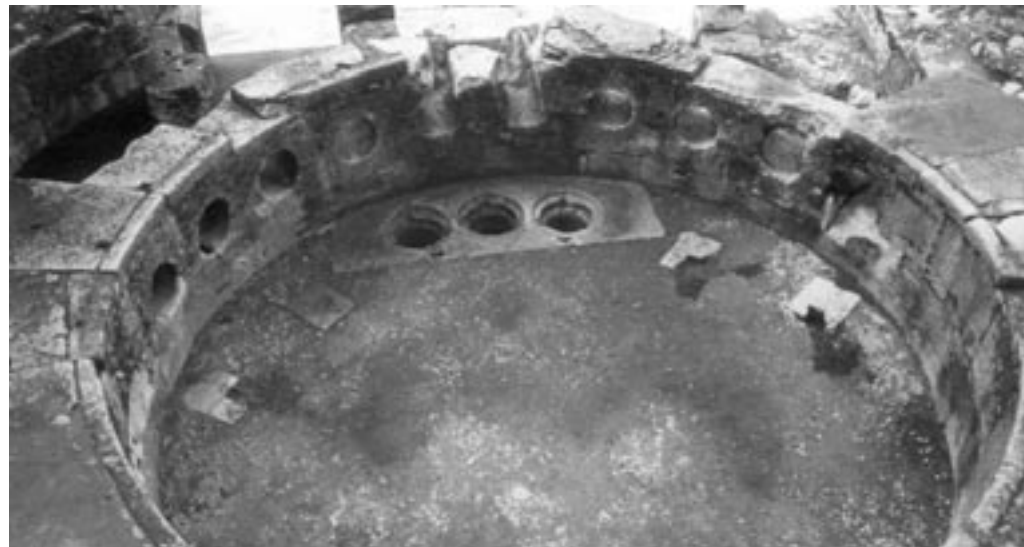
Figuur 2: (onder) Castellum divisorium van Nîmes, 5_m diameter, met 10 uitgaande leidingen in de wand. De 3 openingen in de bodem kwamen uit op een afvalwater kanaal.
