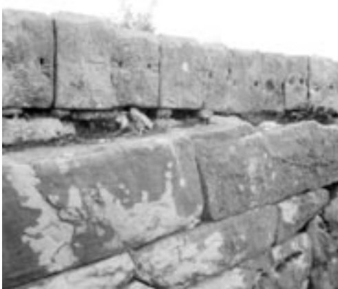
Figuur 28: Delik Kemer siphon van het Patara aquaduct, duvelgaten voor metalen klampen ter fixatie van de leidingstenen.
