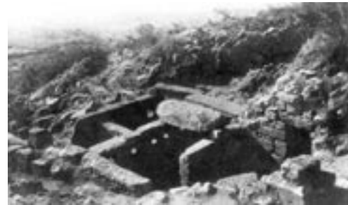
Figuur 30: Instroomtank van de Madradag sifon, toestand in 1913 (naar Garbrecht 1978/1987).
